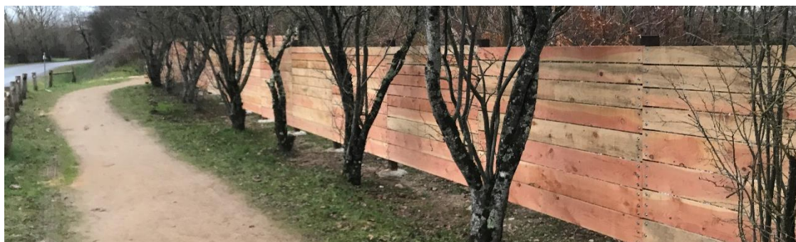
Nouvelle palissade nord
